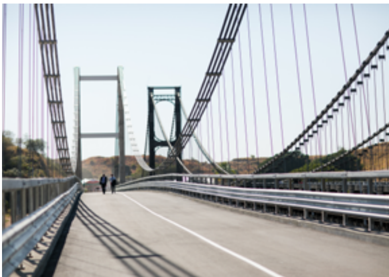
Kamoro (Madagascar) — La construction du nouveau pont suspendu à 2x2 voies et la réhabilitation de l'ancien pont Eiffel de Kamoro ont été achevées en 2017.
