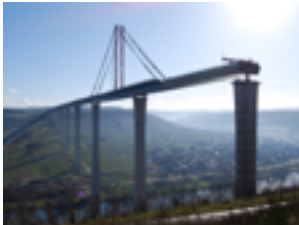
Rhénanie-Palatinat (Allemagne) — Franchissant la Moselle, le pont Hochmosel sera l'un des plus grands viaducs en acier réalisé en Allemagne (1 700 m de long et 150 m de haut).
