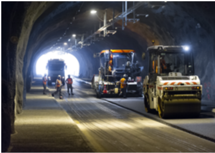
Le Freney-d'Oisans (Isère) — Le tunnel du Chambon a rouvert en décembre 2017, après sa fermeture en 2015 à la suite d'un glissement de terrain.
