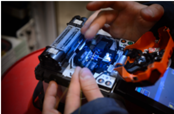
Raccordement de fibre optique.
