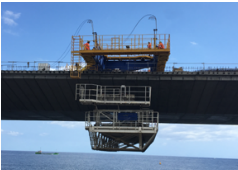
Saint-Denis (La Réunion) — Chantier du viaduc de la Grande Chaloupe.
